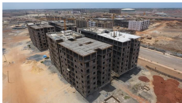
Figure 2 Nouvelles constructions en béton – Pôle urbain de Dianniadio (Crédit EMASOL).
