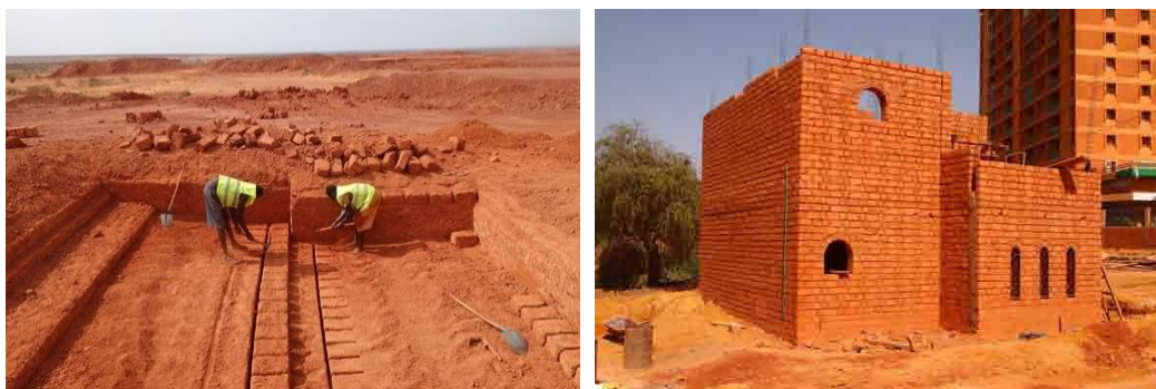
Figure 1 : Construction en BLT sur site Collège Hampaté Ba (gauche) et Prototype d'habitat en BTC (droite)
