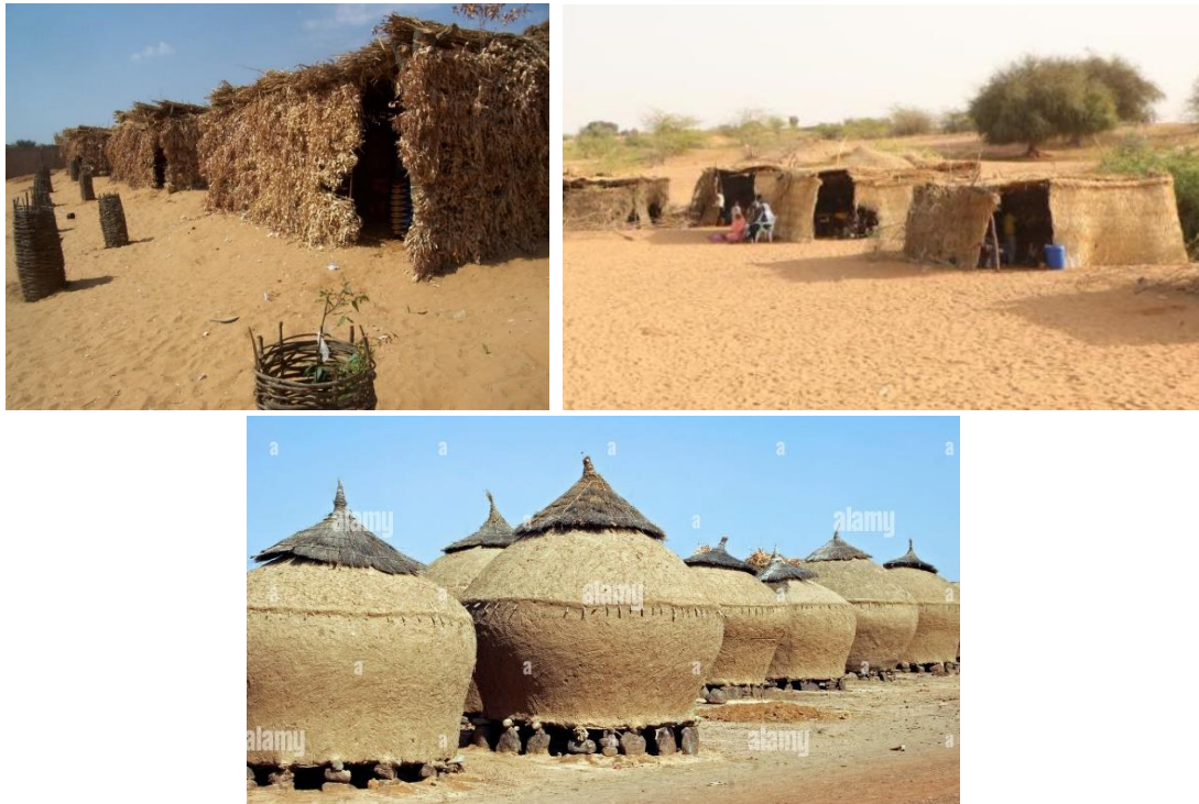
Figure 9 : Salles de classe construites à partir de paille facilement disponible mais hautement inflammable 19 (haut) et Greniers africains traditionnels (bas)
