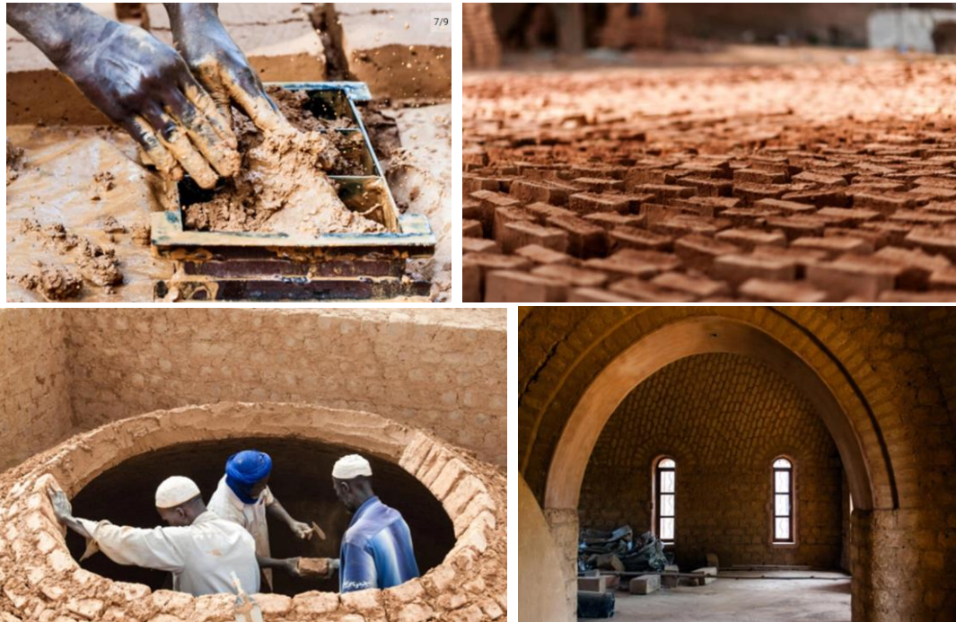
Figure 3 : Malaxage et moulage des petites briques de banco pour la toiture (haut gauche), séchage des briques (haut droit), technique des voûtes et des coupoles (bas gauche et droite) 8
