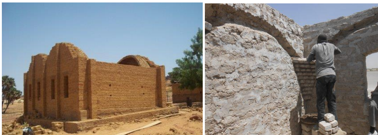
Figure 7 : Construction d'une voûte en banco (gauche), construction de coupole (droite) 16
