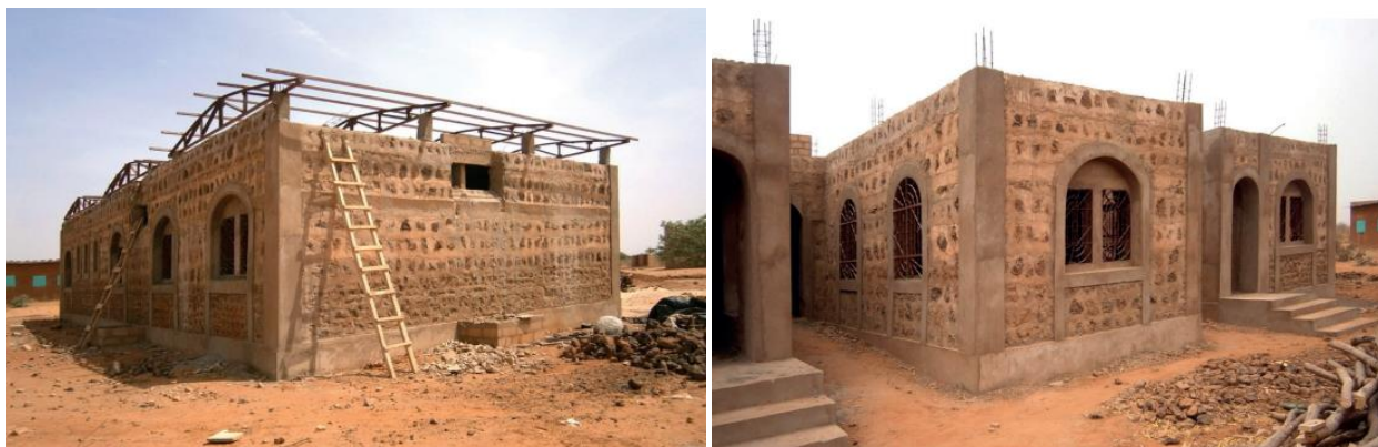
Figure 8 : Vue des maçonneries en construction Pierre de pays
