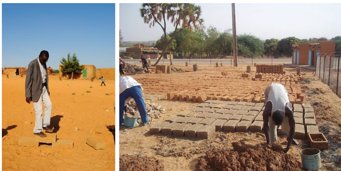
2013 : Construction de la plateforme
