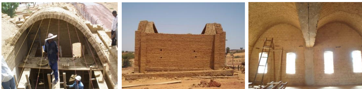
2013 : Construction en voûte Nubienne, Juillet 2013 fin de la construction du bâti (droite)
