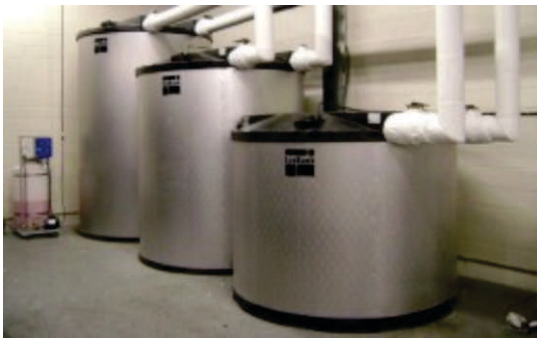
Figure 90 : Cuves de stockage à échangeur interne Source : http://www.calmac.com/
