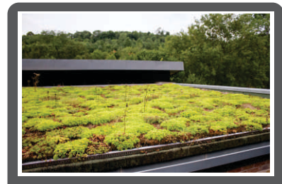
Figure 49 : Les plantations en toiture
