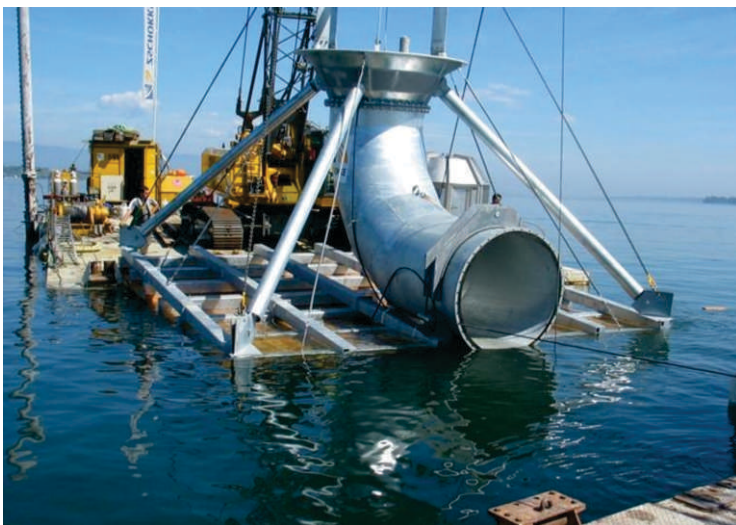
Figure 73 : Pose de canalisation pour eau de rafraîchissement/condensation
