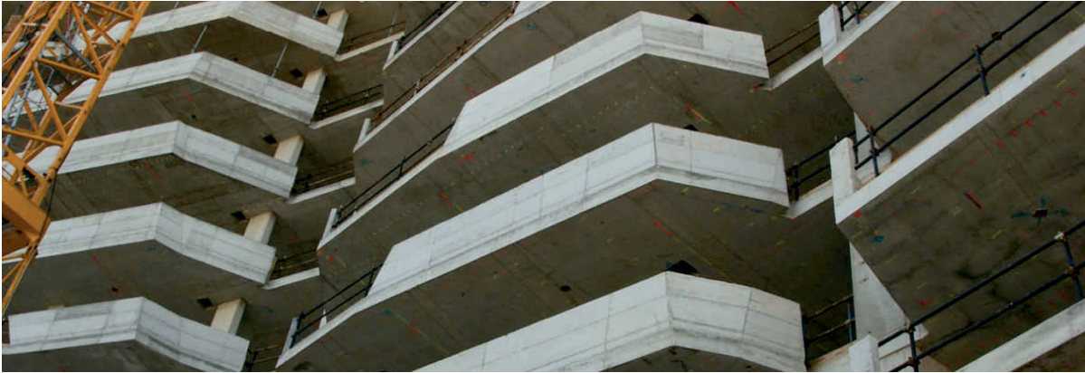
Figure 43 : Les avancées de poutre
