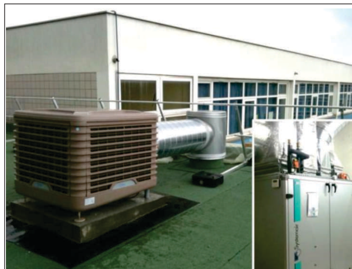
Figure 100 : Installation d'un caisson de refroidissement adiabatique direct en toiture
