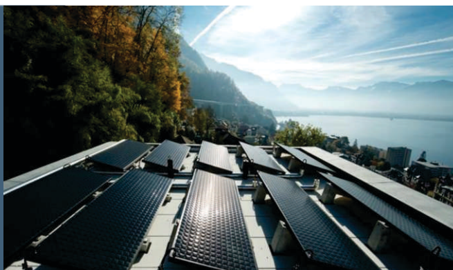
Figure 129 : Capteur plan sans vitrage
