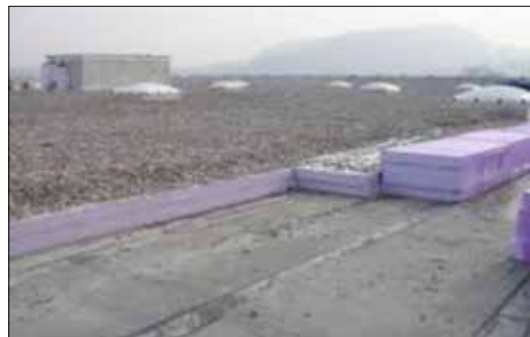
Figure 40 : Isolation de la toiture avec lestage
