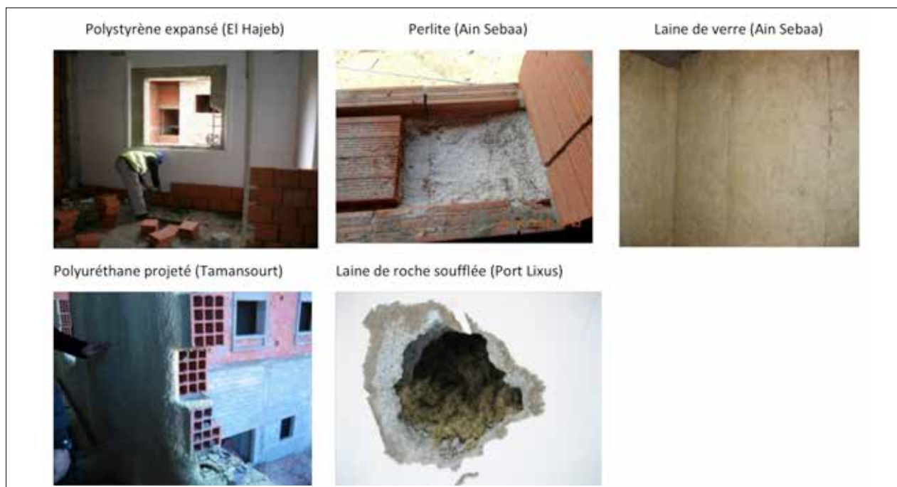
Figure 42 : Isolation des murs
