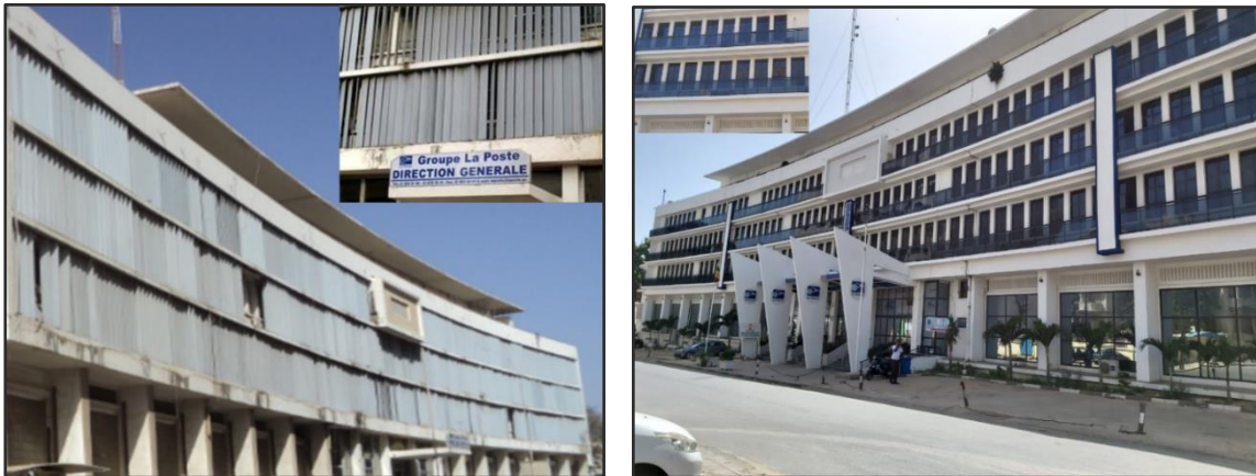
Figure 14 : Direction générale de la poste avant et après la rénovation (Crédit EMASOL)
