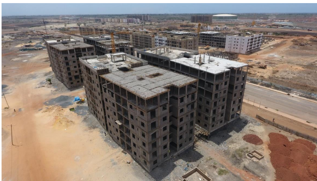
Figure 12 : Nouvelles construction en béton – Pôle urbain de Diamniadio (Crédit EMASOL).
